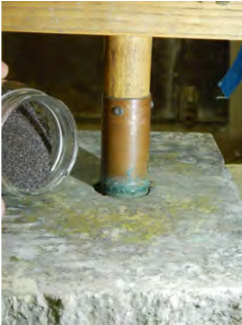
Abb. 8 Bohrkronen im halbfertigen Bohrloch und Schleifmittel im Glas links.
